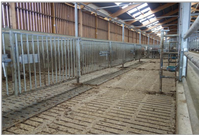
Abb. 11: Umschwenkbare Gitter erleichtern den Umgang mit den Tieren beim Einstallen, Umbuchten oder insbesondere beim Ausstallen (Foto: LWK Niedersachsen).
